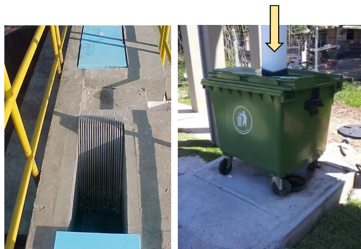
Figura 5. Exemplo de gradeamento em canal de chegada e do material retido.
