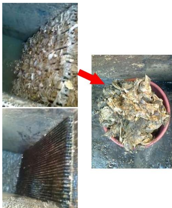
Figura 3. Exemplo de gradeamento em canal de chegada e do material retido.
