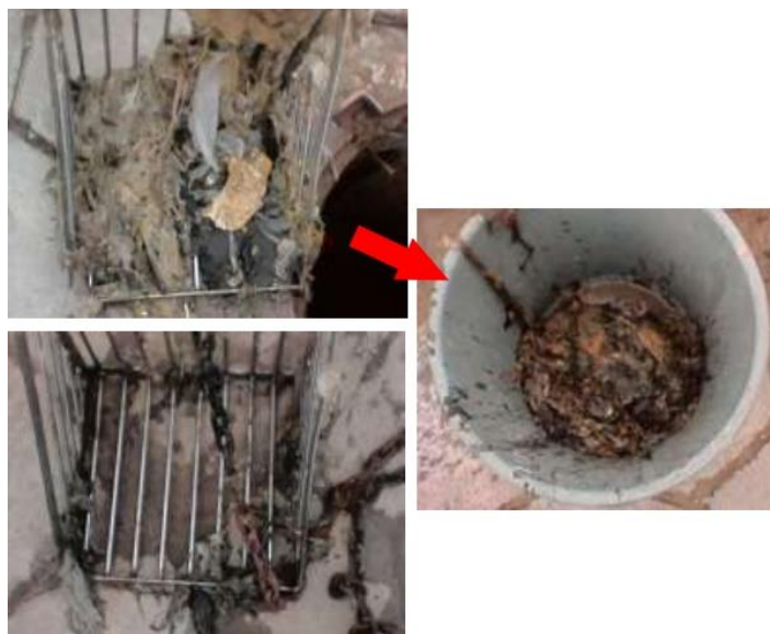
Figura 2. Exemplo de gradeamento por cesto e material retido.
